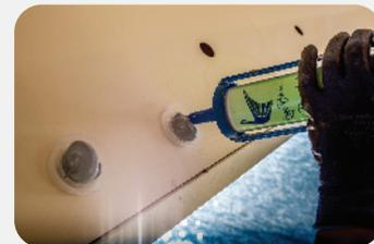
1. La surface doit être nettoyée et séchée avant application. Ne pas appliquer le produit lors de jours de pluie afin d'éviter tout problème d'adhérence du silicone.
